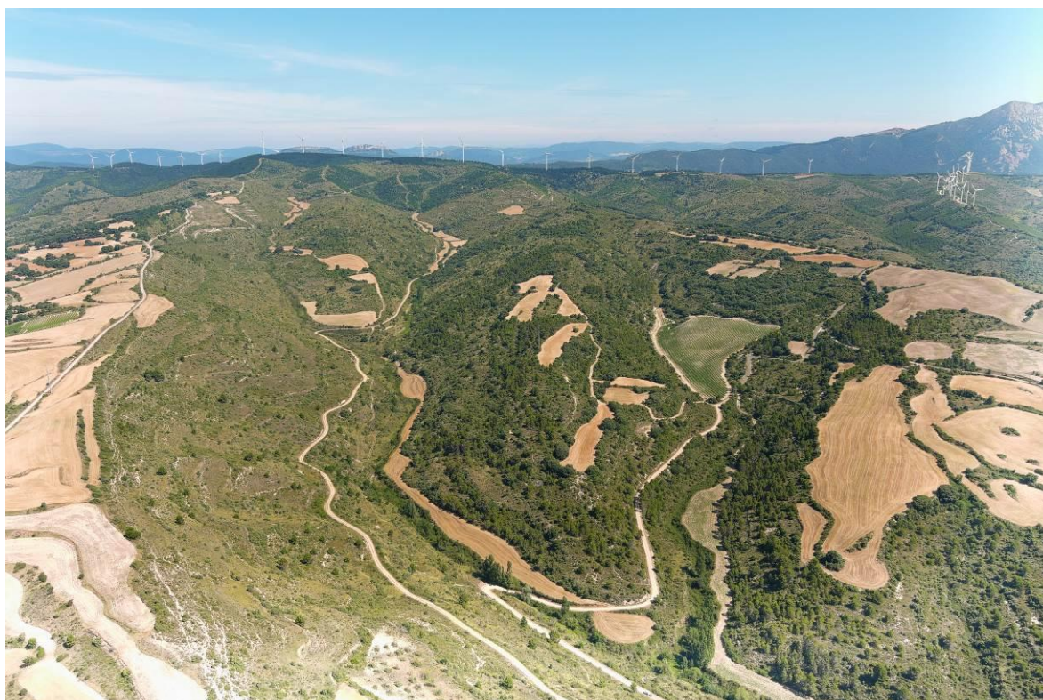
Ilustración 1 Panorámica de la zona de ocupación del Plan Especial a través de vuelo de dron
