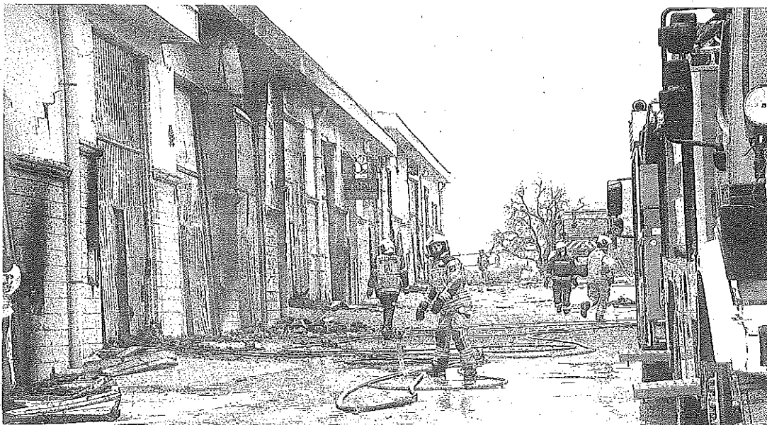
Un grupo de bomberos sofoca el incendio que se presentó en el polígono de El Portillo, de Samaniego. de MIGUEL HERREROS
