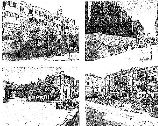
Obra en Rioja Mayor, calle Florida, arriba, y plazas Mayor y Vitoria.
