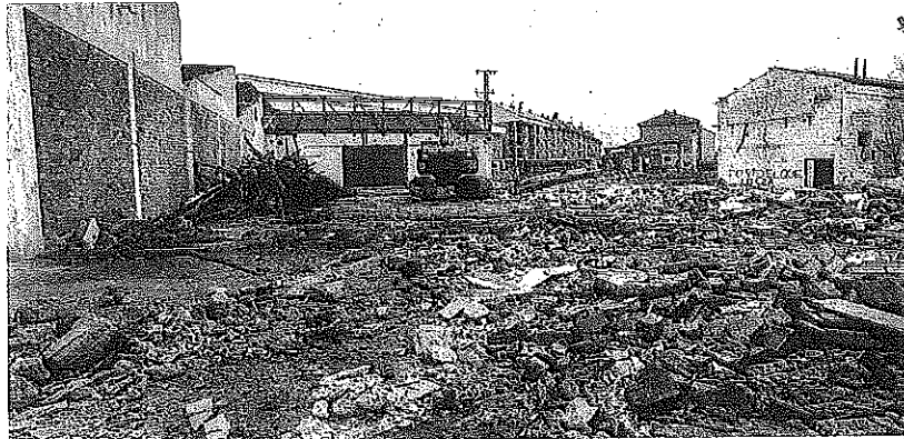
El derribo de la antigua fábrica de Curtidos se realizó en enero. || EL CORREO
