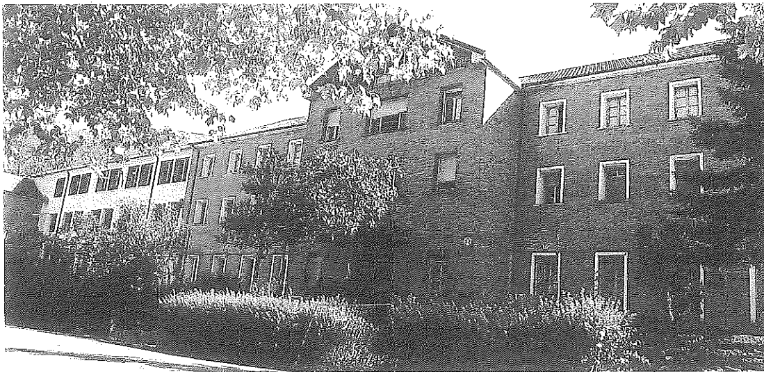
Panorámica del edificio que se está recuperando poco a poco.
