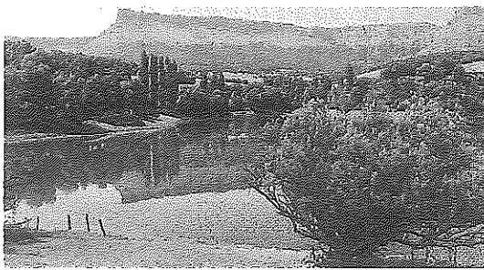
Maroño es la principal infraestructura hidráulica de Ayala. S. ESPINOSA
