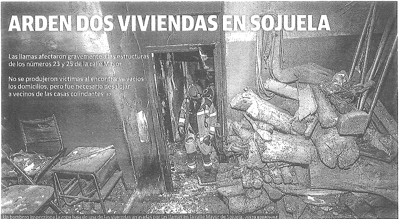
Un bombero inspecciona la zona baja de una de las viviendas arrasadas por las llamas en la calle Mayor de Sojuela. Justo a la izquierda.
