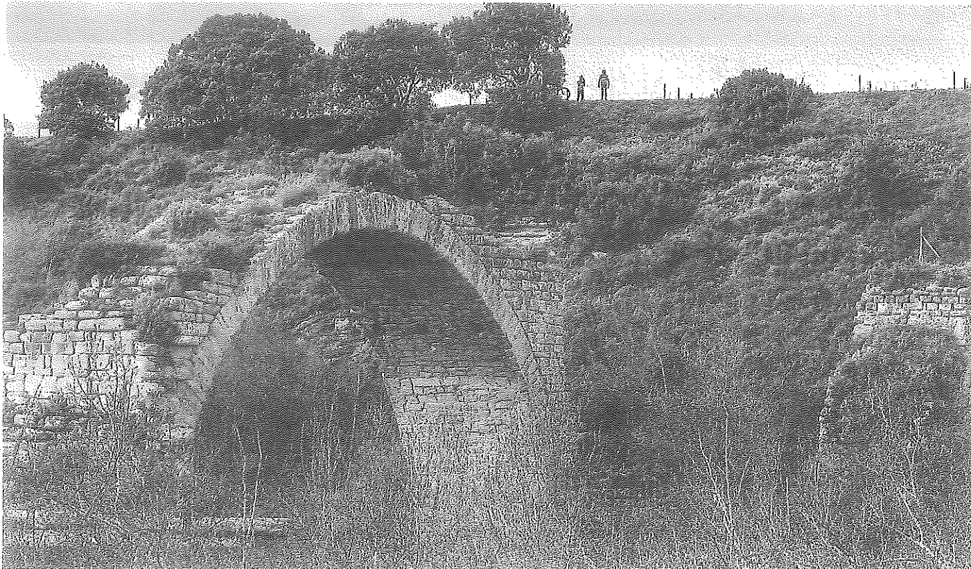
En primer término, entre la maleza y los árboles arrastrados por la corriente, la parte alavesa del puente, del que brota abundante vegetación. Detrás, el arco caído. IGOR MARTÍN
