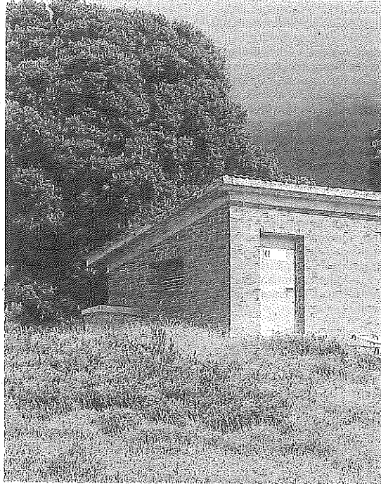
Caseta de alta de agua en la zona del nuevo depósito. Foto: P.J.P.
