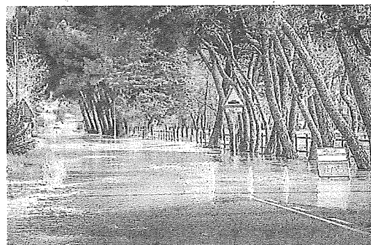
Carretera cortada en el Pozo Cubillas por inundación. J. RODRÍGUEZ
