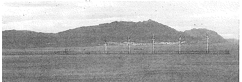
Los cinco aerogeneradores de Punta Lucero, el último parque puesto en marcha en la CAV. Foto: J. Lazkano
