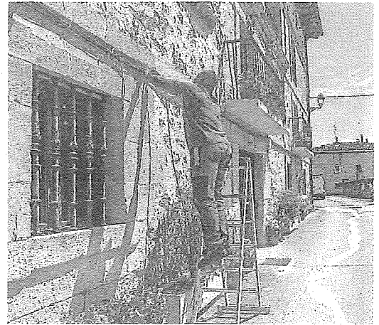
Un operario instala cable de fibra óptica en Lagrán. IGOR AIZPURU
