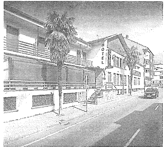
Las obras en el hotel están paralizadas a falta de financiación. e. c.
