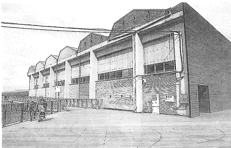
El frontón se va a demoler y será sustituido por un nuevo pabellón multidisciplinar. BLANCA CASTILLO
