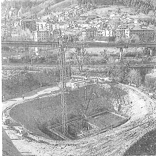
La obra conectará los colectores con el bombeo de Llodio. Azvi
