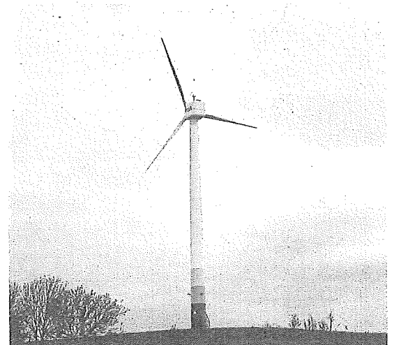
Molino de generación de energía eólica.
