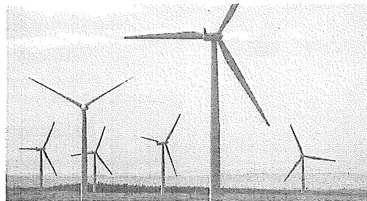
18 parques eólicos están en proyecto en Álava. e. c.
