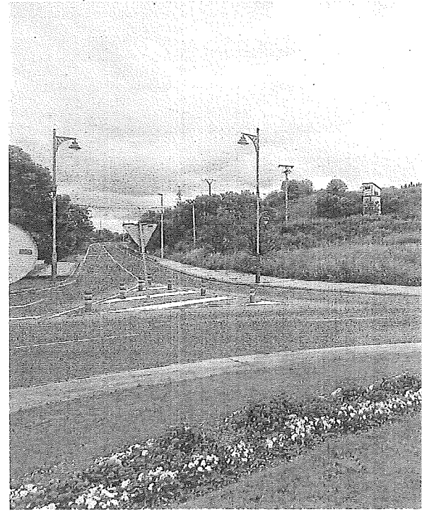
Rotonda de El Campillo, con el tramo de carretera bajo la cual se construirá
