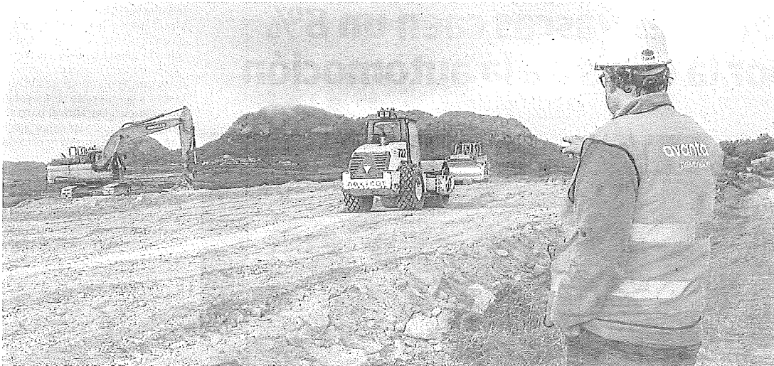
Las máquinas trabajan ya sobre el terreno para construir el parque de Labraza. BLANCA CASTILLO
