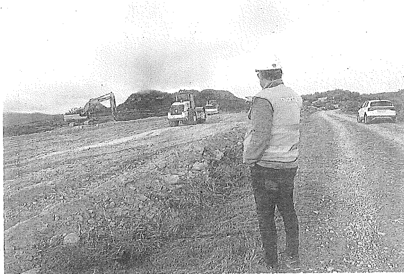
Trabajos de acondicionamiento para el parque eólico que desaprueba el pueblo de Labraza. BLANCA CASTILLO
