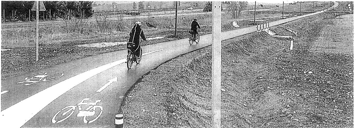
La vía ciclista al parque tecnológico de Miñano acaba de estrenar hace poco su primer tramo, ejecutado por la Diputación y que va de Araca al polígono empresarial. RAFA GUTIÉRREZ
