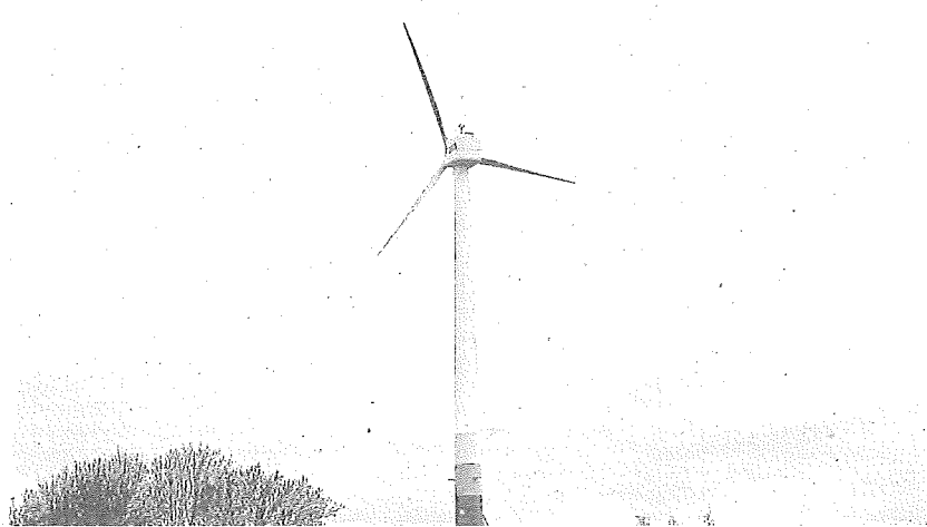
Molino de viento en el Parque Tecnológico de Álava. Foto: pilar Barco
