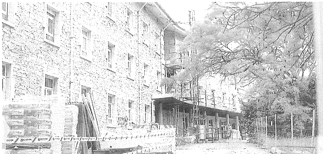
Estado de las obras en el Centro de Refugiados de Arana el pasado mes de junio. Foto: Jorge Muñoz
